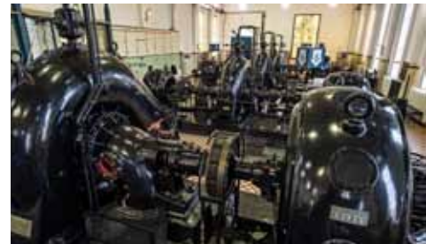
Die alte Pumpenhalle
